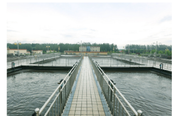
水利工程 河北省水利工程局 Hydraulic project—Hebei Water Conservancy Engineering Bureau
