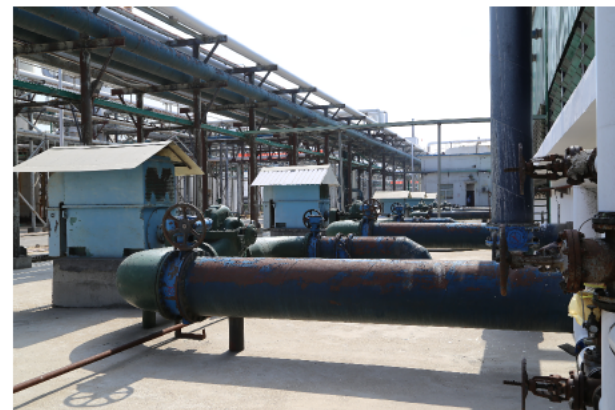
鹤壁宝马科技集团应用现场（型号：500S22A 数量：9台套） Hebi Baoma Technology Group Co., Ltd working site (model:500S22A,Quantity:9 sets)
